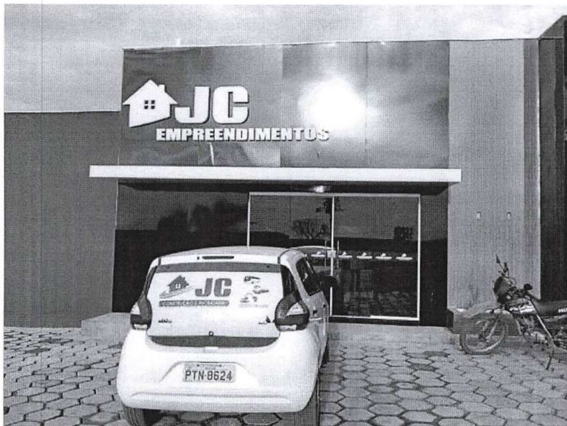
FOTO 01 – PARTE EXTERNA (FACHADA JC EMPREENDIMENTOS)
