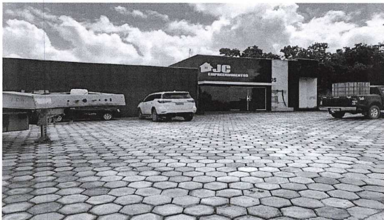
FOTO 03 – PARTE EXTERNA (GARAGEM)
