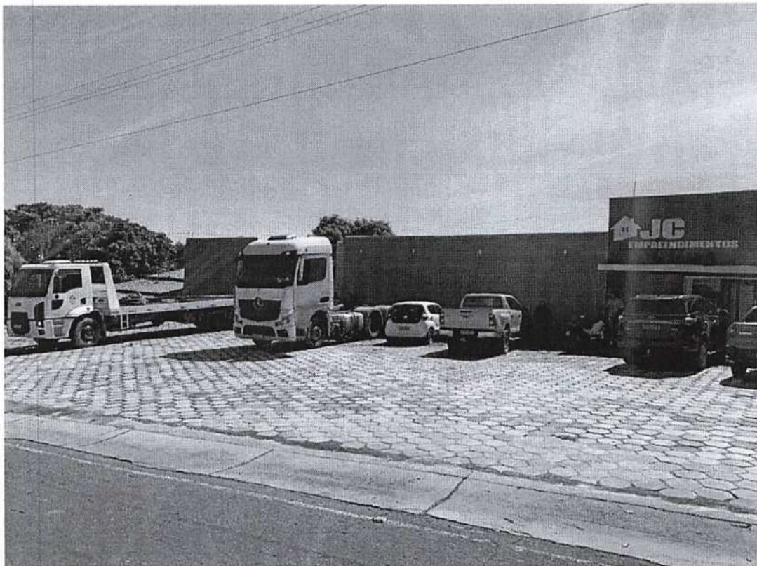
FOTO 09 – PARTE EXTERNA (GARAGEM)
