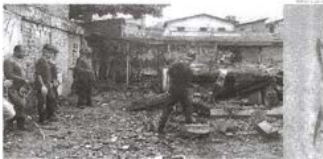
Operários iniciam a demolição do prédio atual onde será erguida uma nova estrutura do Mercado do Monte Castelo.
